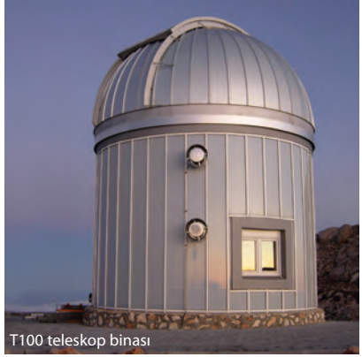
T100 teleskop binası
